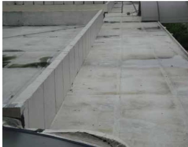
Se realizaron diversos trabajos de impermeabilización, así como la instalación de chova en el tumbado de las aulas 600 y 300.
