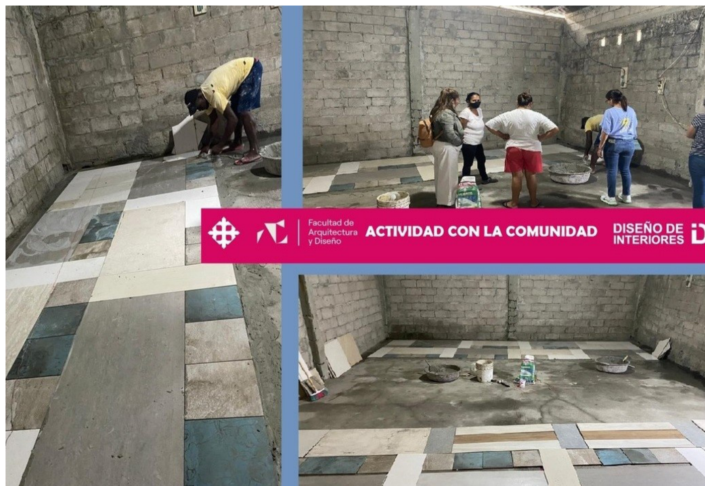
Instalación de piso en casa comunal
